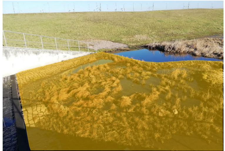
Abbildung 7: Auszüge Fotodokumentation Klemm & Hensen GmbH, 21.02.2022, Befestigung belassen (grün), Befestigung zurückbauen (orange)
