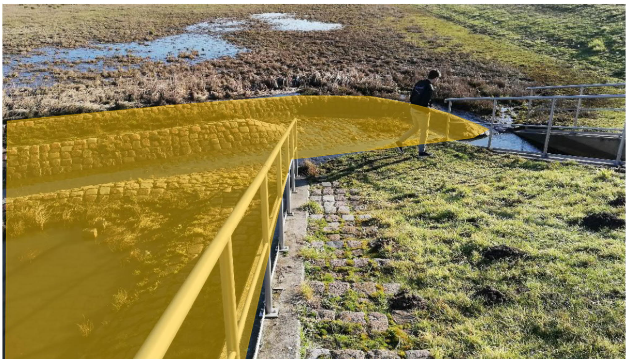
Abbildung 8: Auszüge Fotodokumentation Klemm & Hensen GmbH, 21.02.2022, Befestigung zurückbauen (orange)
